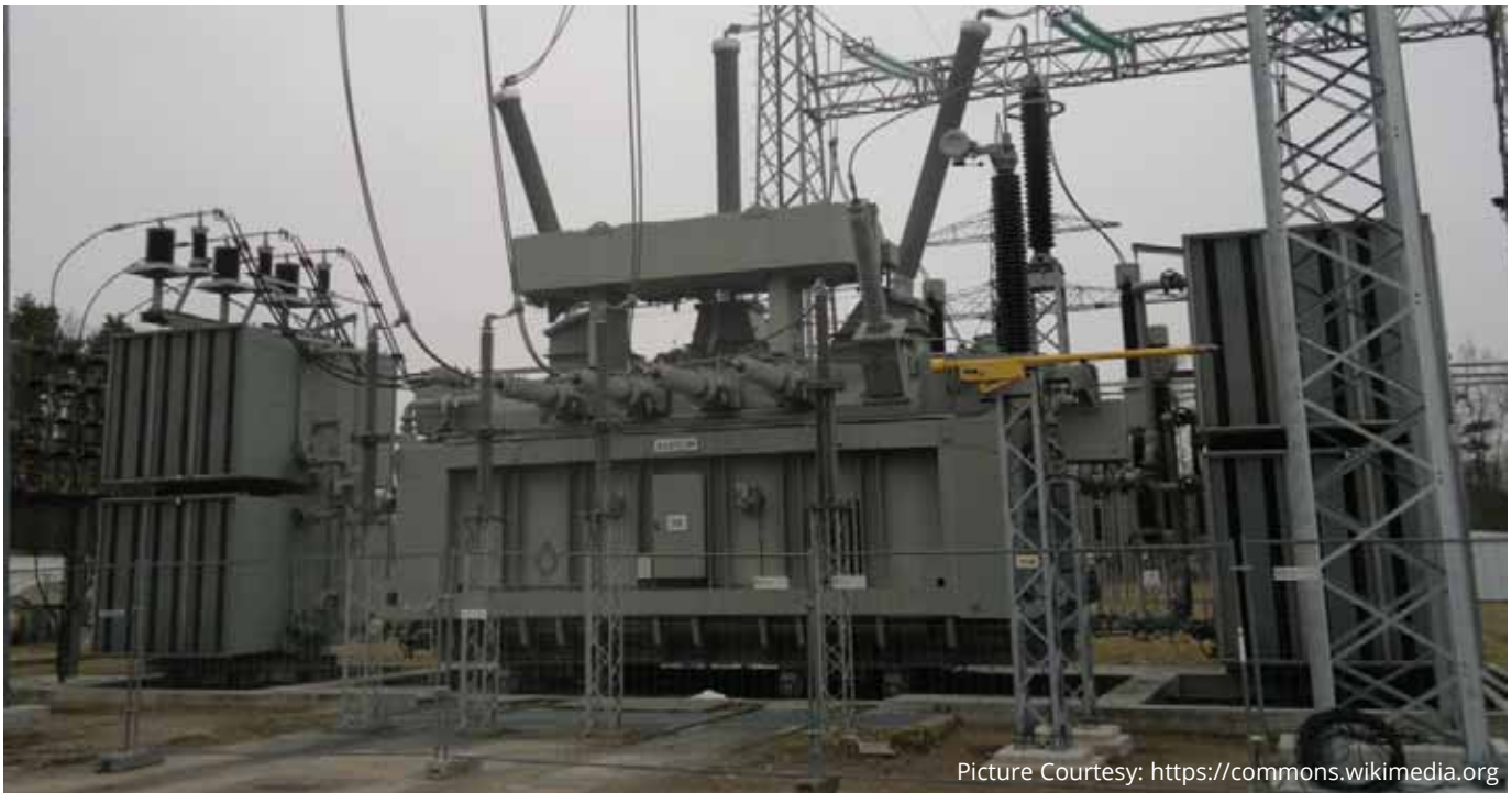
380/110kV Transformator im Umspannwerk Kriegenbrunn
